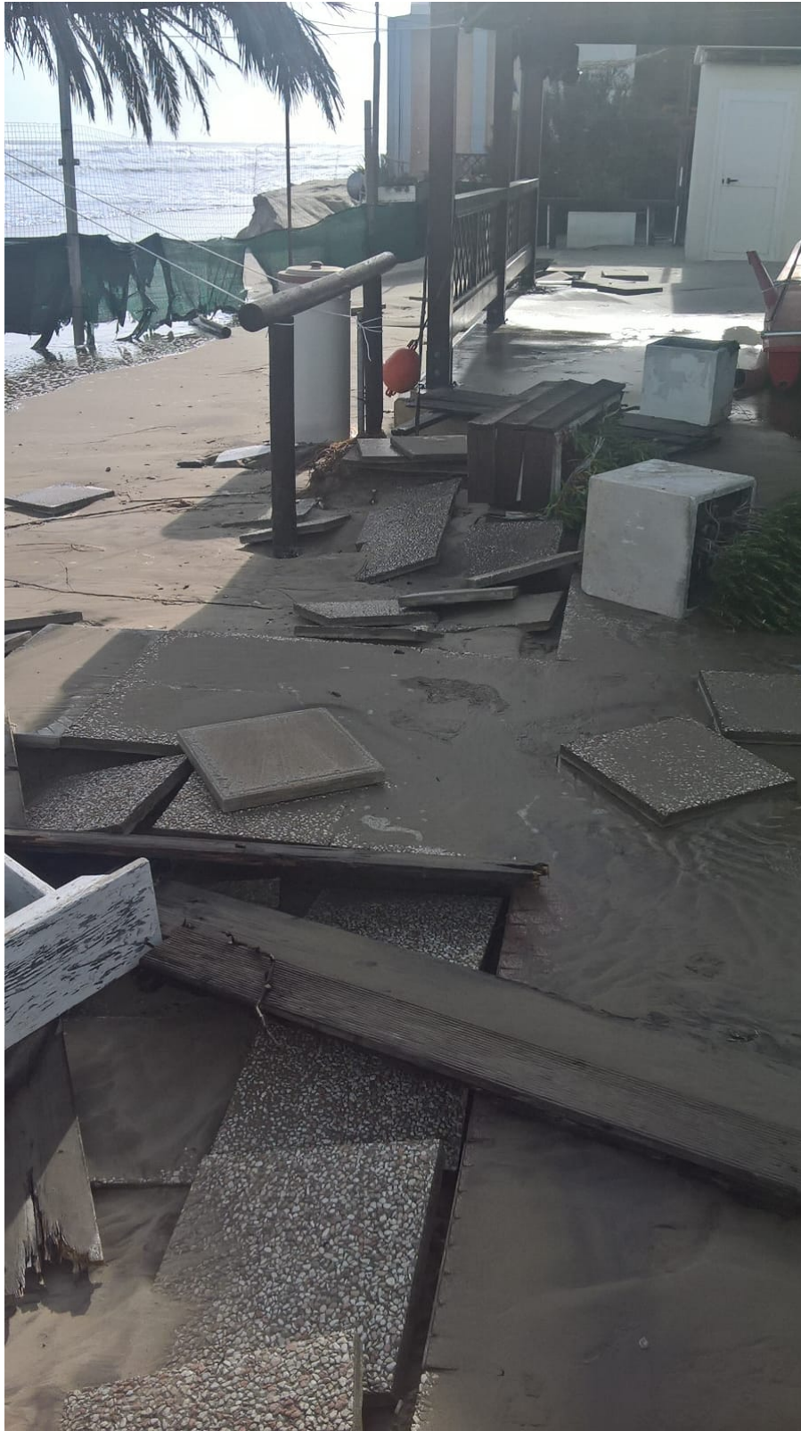
Figura 12: Allagamenti dei locali in prossimità della foce del fiume Musone - 13 Novembre
